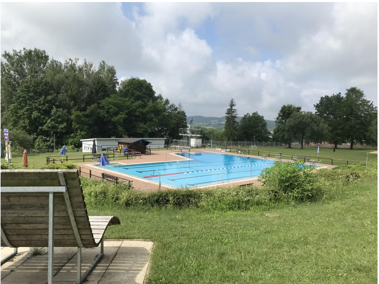
Das Bild zeigt das Freibad im Ortsteil Sterbfritz
